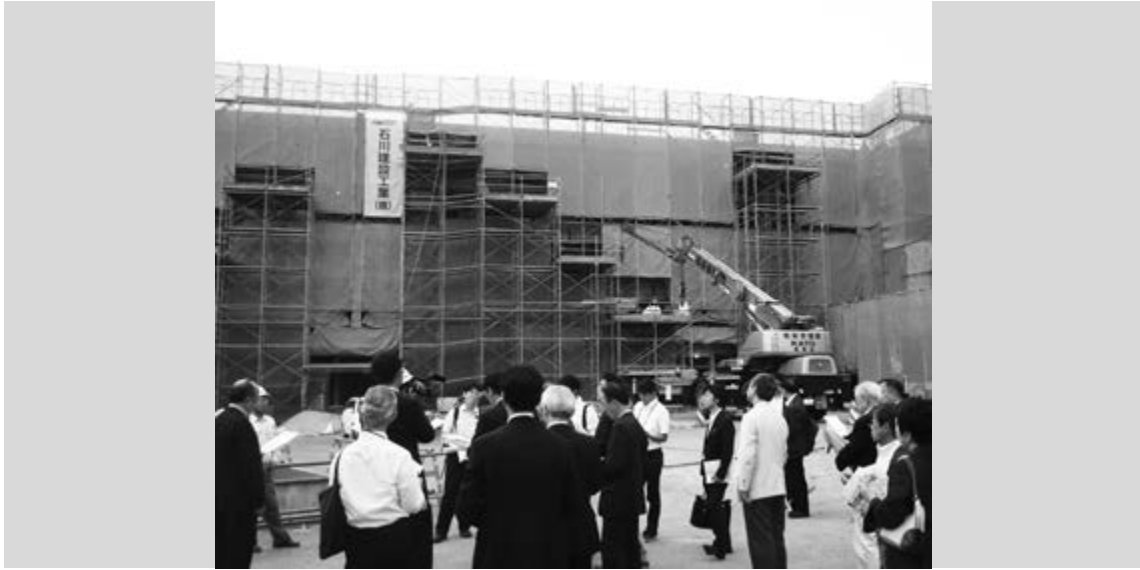
南相馬市災害公営住宅
