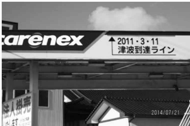
ガソリンスタンドの屋根に記載された津波到達ライン
