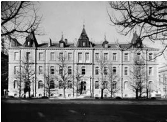
丸の内の三菱1号館（東1号館）
