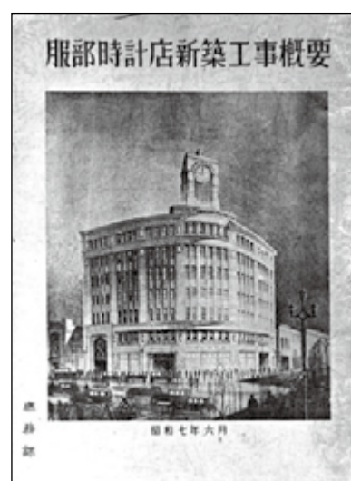
1932年（昭和7）服部時計店新築工事概要
