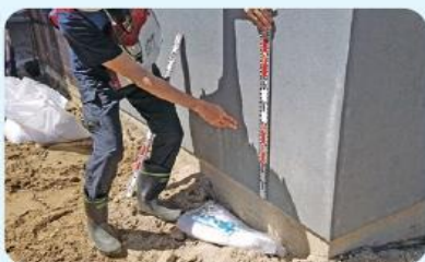
浸水深の確認作業
